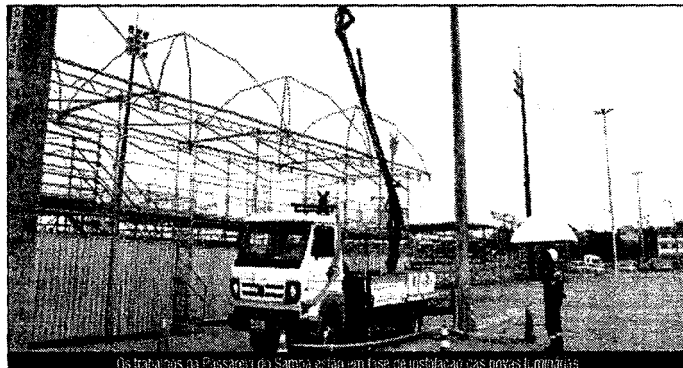
Os trabalhos na Passarela do Samba estão em fase de instalação das novas luminárias.
